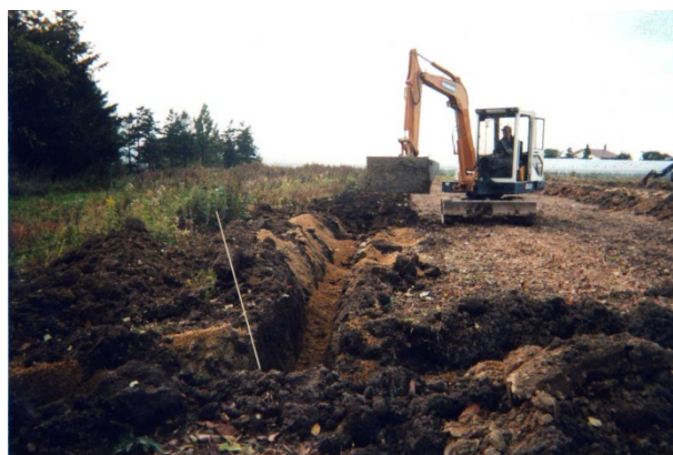
自力施工による透排水性の改善
