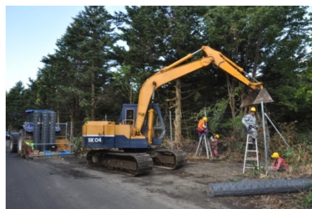
自力施工によるエゾシカ防護柵設置
